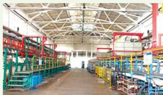
建设工业热表厂表处理线
