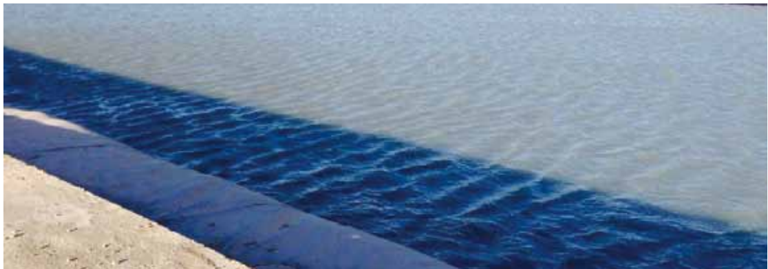
埃及 NPIC 项目公司 + 分离处理后污水晾晒池
