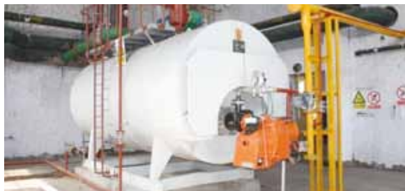
河南中光学燃气锅炉改造
