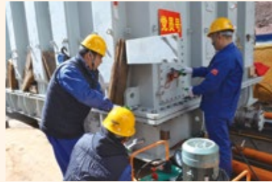
保变电气“党员号”变压器现场组装
