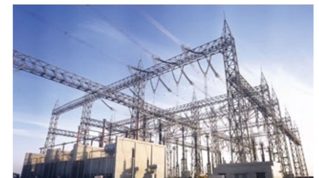
晋中现场组装变压器
